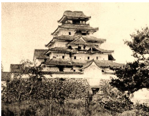
損傷した会津若松城
